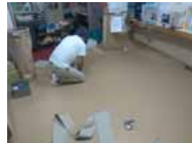
寮母室床張り替え
