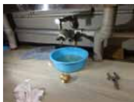
洗面所サーモスタット交換
