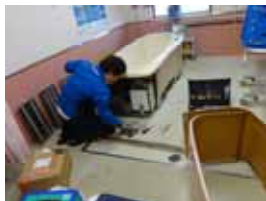
特浴加圧ポンプ修理
